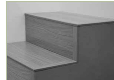
Altura = altura do degrau + o Eucafloor + Manta, instalados na base da escada
