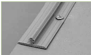
Detalhe do Perfil Base Tecno fixado
